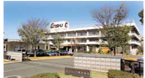
本社及び高塚工場
