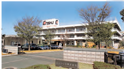
本社及び高塚工場
