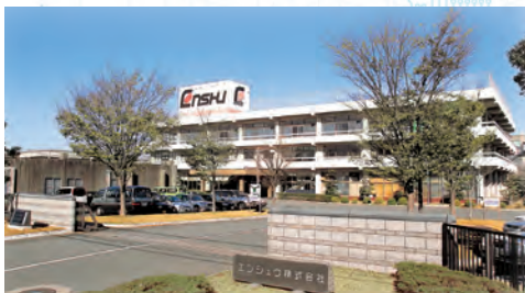
本社及び高塚工場
