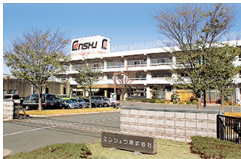
本社及び高塚工場
