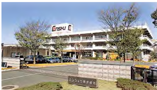
本社及び高塚工場
