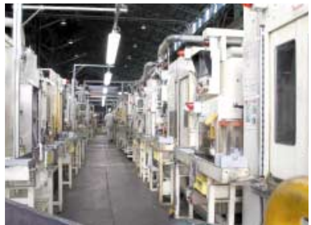
デフケース加工設備
